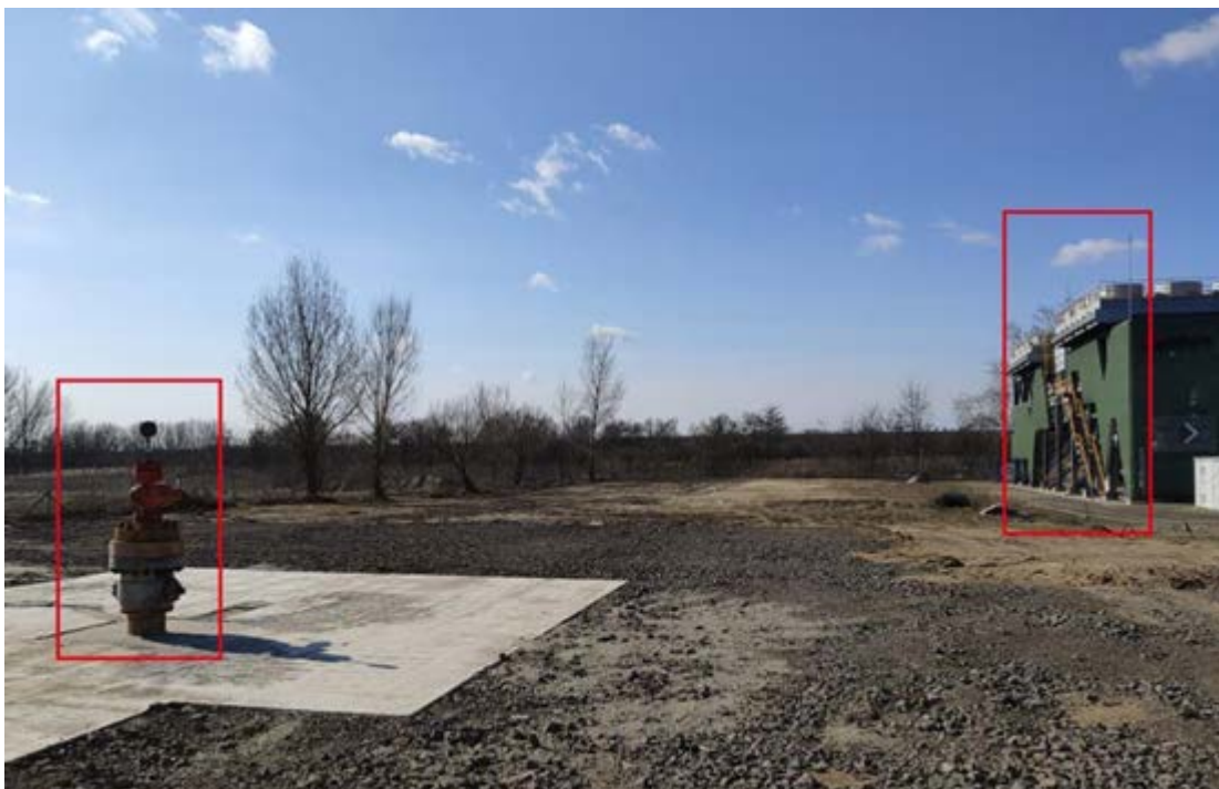
匈牙利Turawell项目一期和新打的井
